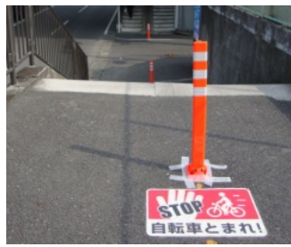
設置された自転車止めのポール
