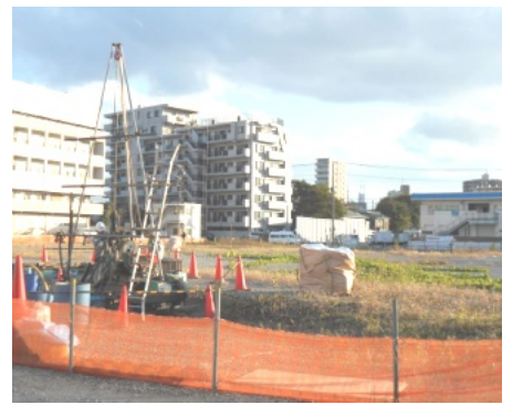
南部給食センター建設予定地 (幸区南幸町3丁目)
