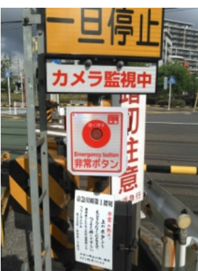
反射する素材に変更された八丁驛駅前踏切非常ボタン
